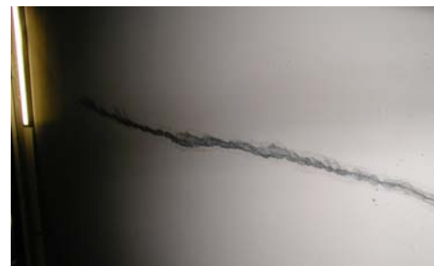
Fissure visible en sous-face d'une prédalle.
