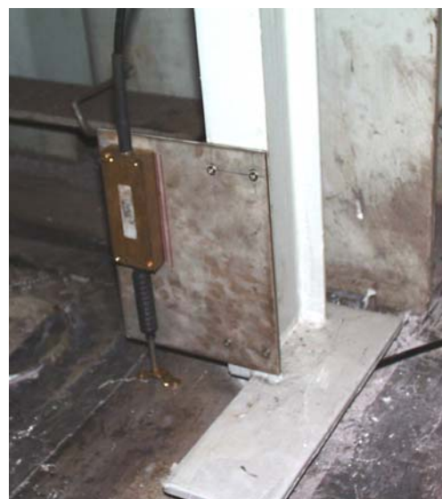
Zoom sur un des extensomètres optiques verticaux avant protection
