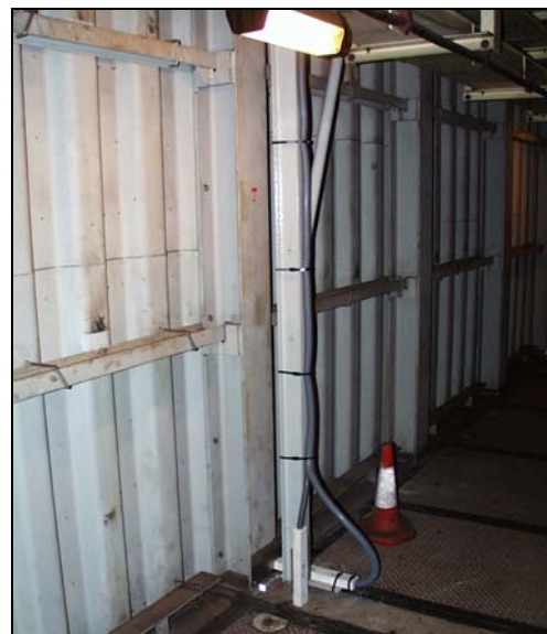
L'une des 3 potences verticales sur laquelle sont fixées les 2 extensomètres optiques
