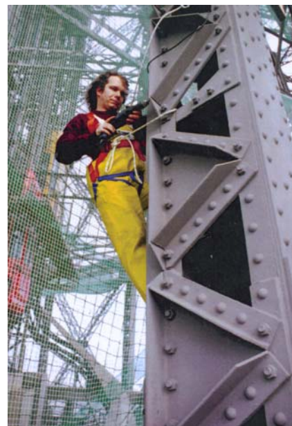
Installation d'une Corde Optique sur un arbalétrier du Panneau 13
