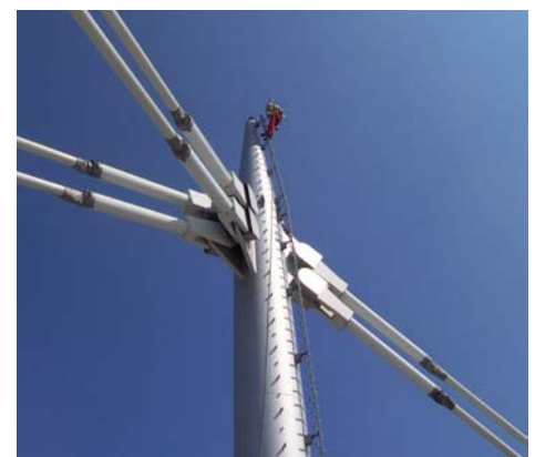
Installation d'un anémomètre en tête de poteau
